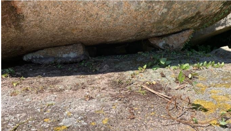
Figura 20 – pedaços de granito apoiando a Plataforma
