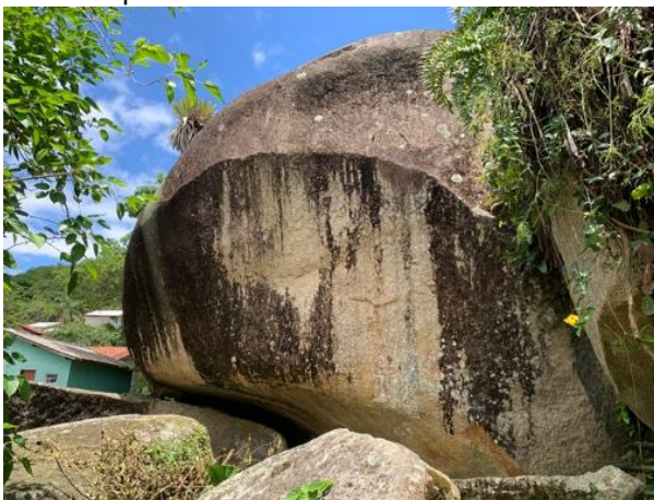
Figura 23 – a iluminação destaca a falha geológica e permite ver que a lasca não caiu e sim removida e levada para cima
